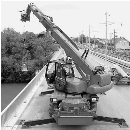
Bild 5 Fahrzeugkran: Teleskopstapler mit Seilwinde
